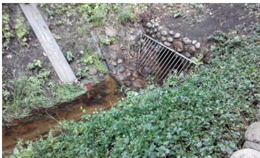
Abfluss Graben 2 Wehrdeich 87
