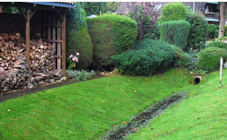
Optimal unterhaltener Entwässerungsgraben
