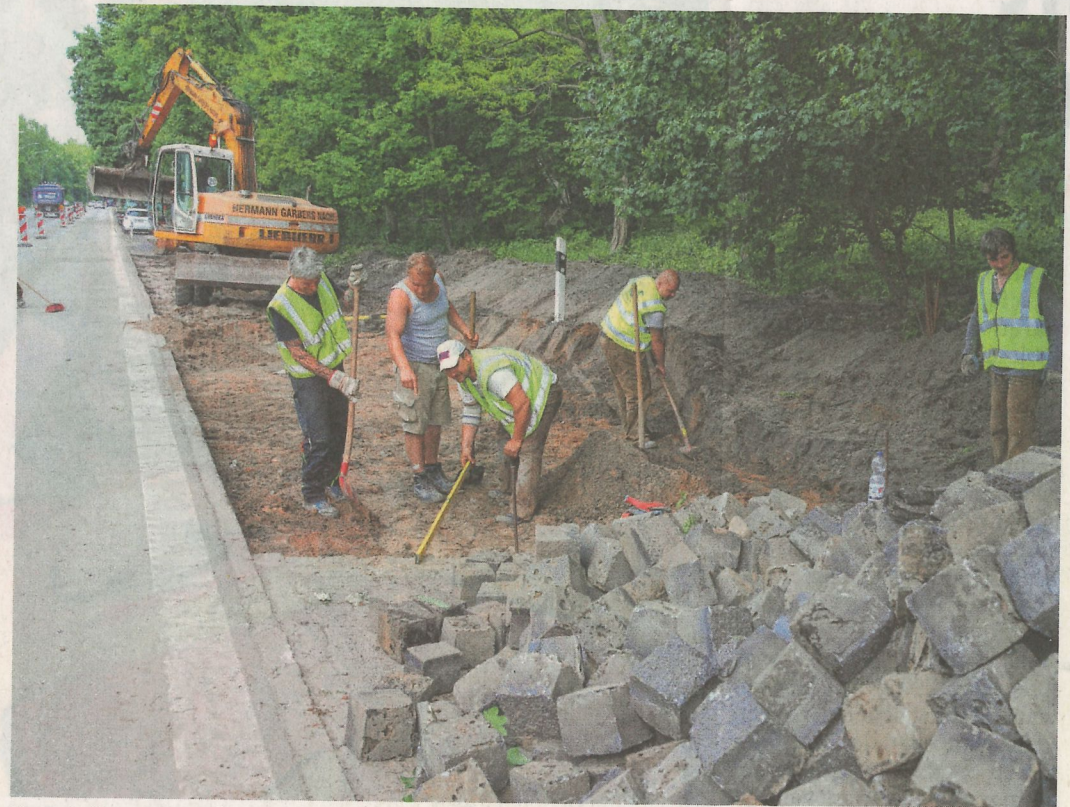
Bauarbeiter setzen den unterspülten Rad- und Gehweg an der B 5 instand: Die Arbeiten an dieser Baustelle werden noch eineinhalb bis zwei Wochen dauern.
