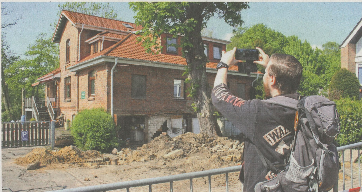
Unwetterschäden in Oststeinbek am Tag danach: Viele Neugierige sind Freitag zur Mühle gekommen, um sich die eingestürzte Mauer anzusehen. Bewohnbar ist der 350 Jahre alte Bau vorerst nicht. Fotos: Gerullis / Busse (4)
