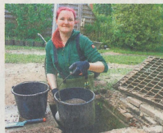
Dominique Szulereczki hilft ihren Schwiegereltern die Schäden zu beseitigen.
