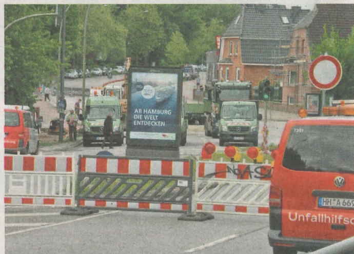
Vollsperrung bis Freitagmittag: Der sonst winzige Bornmühlenbach hat die Habermannstraße überspült, den Fußweg weggerissen.
